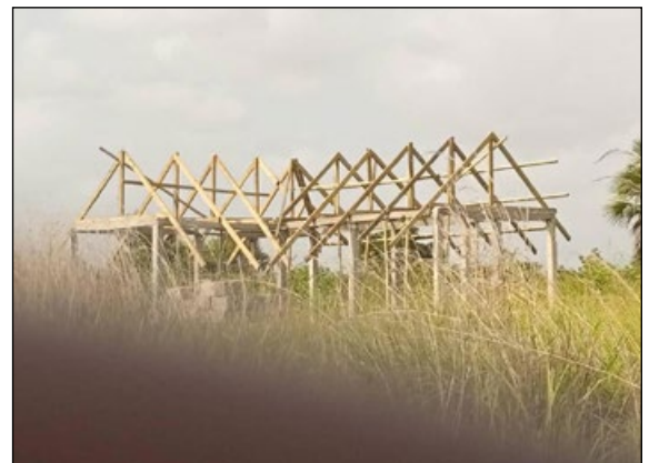
Celosía del tejado para una casa nueva
