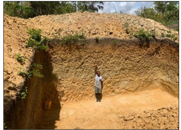
Excavación de un sótano
